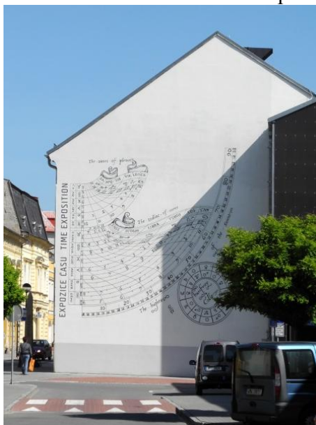
Obrázek 1 - Budova muzea ve Šternberku na ulici ČSA 19.
